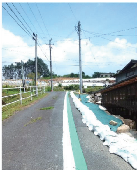
写真3 宅地への流入を防止するための土嚢
