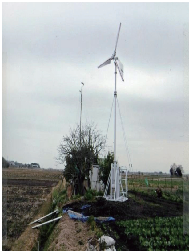
写真1 改造小型水平軸風車実験装置実景
