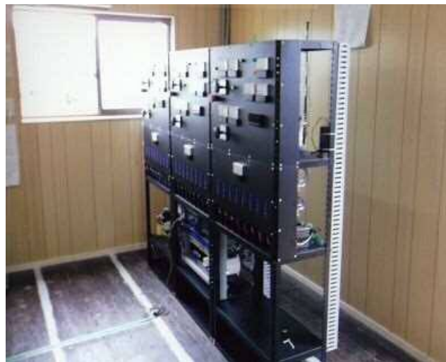
図 15 : 風車コントローラ
