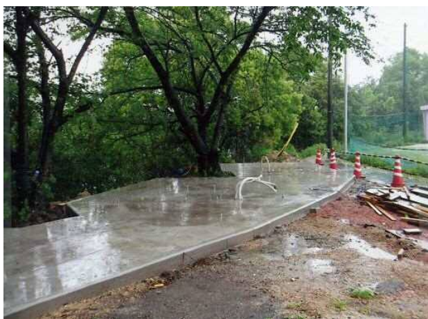
図 11 : キクタケスポーツヒルズに作られた風車の基礎
